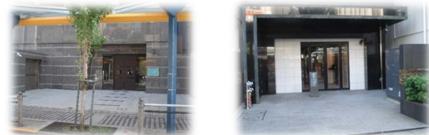
東口商店街に建設されているペンシルビル
